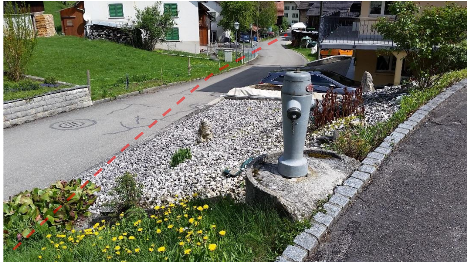
Abbildung 3: Abschnitt 1: Eingedolter Verlauf DBK (rot) unter Privatparzellen und Strasse (Blick in Fliessrichtung)
