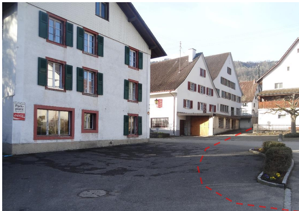
Abbildung 4: Abschnitt 2.1: Eingedolter Verlauf DBK, (Blick gegen die Fliessrichtung)
